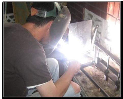
Una vez colocadas las tapas laterales, se soldó a estas, un refuerzo angular en la parte superior, para facilitar la manipulación y el transporte de la máquina (*Fotos 29-32*).
