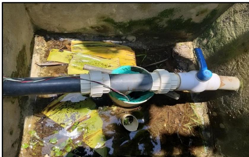
Figura 23. Fig. 23. Montaje sensor de nivel de profundidad in situ.
