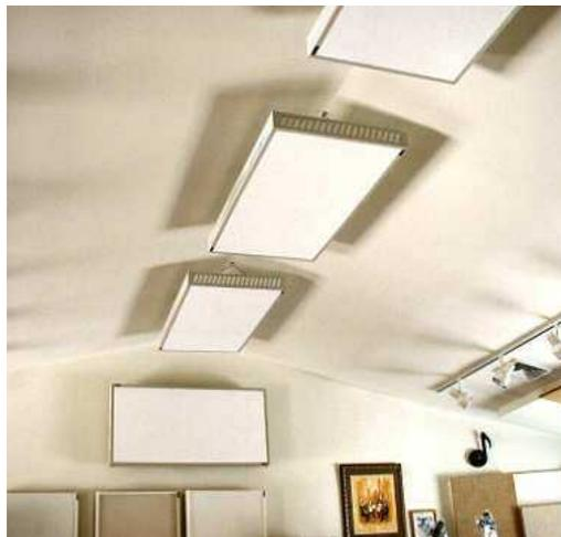
**Fig. 13.** Las pequeñas trampas (Paneles acústicos) son instaladas abajo del techo en forma de pico.
