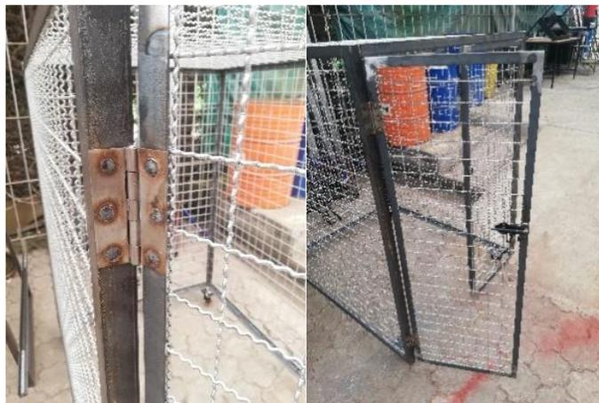
*Figura 46 Instalación de puertas*
