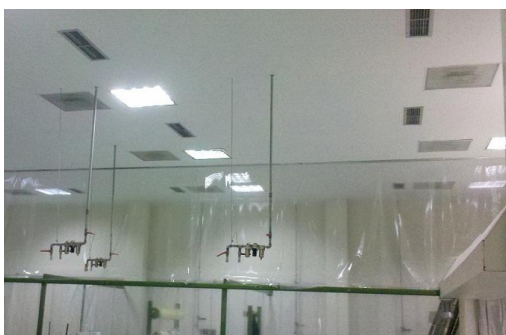
Figura 45. Sistema de extracción de aire hangar Fuerza Aérea Colombiana Fuente: http://abaco.com.co/ventilacion_mecanica.html
