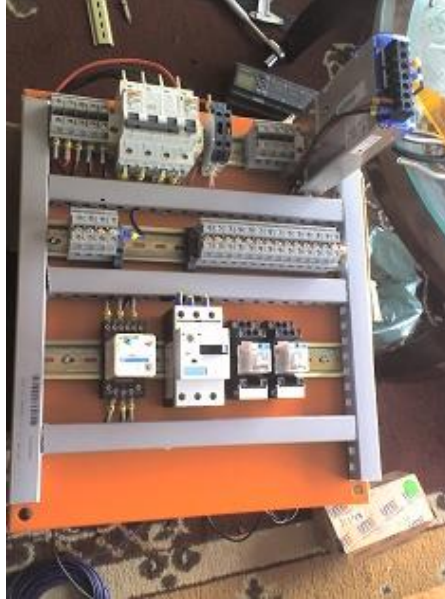
Figura 83. Ubicación de los elementos en el tablero
