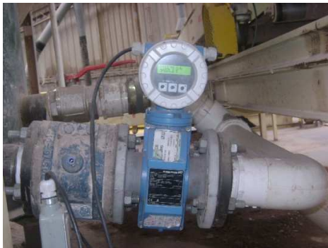
Figura 72. Montaje contador y válvula.
