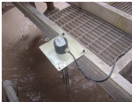
Figura 71. Montaje sensor nivel tanque.
