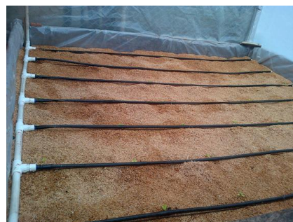
d) Instalación sistema de riego
