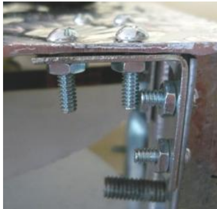
Figura 78. Uniones de las diferentes partes del esqueleto con tornillería.
