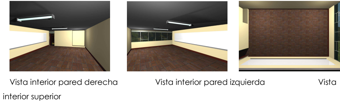
FIGURA 41. Condiciones originales del salón 306 del edificio Pedro Simón
