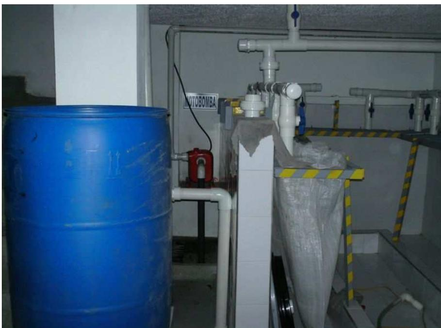
Foto 16. Vista posterior -planta de tratamiento de aguas residuales
